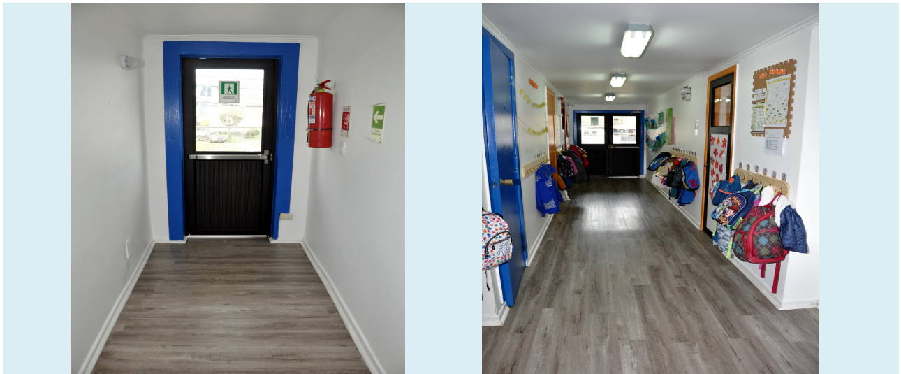
Fig. N° 5 Vistas entradas y salidas de emergencia
